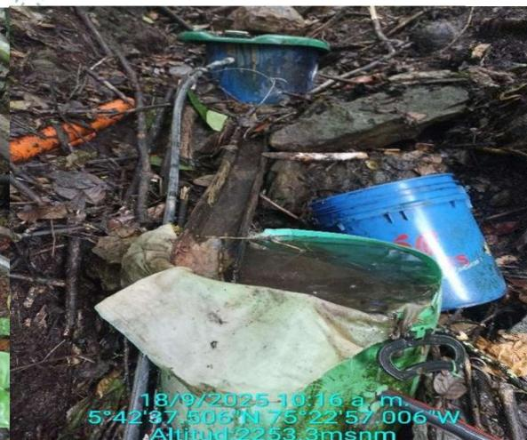
**Obra de captación implementada similar a la recomendada. Se debe colocar un tapón en que pasa el agua a la segunda caneca y calibrarlo de acuerdo a los diseños y caudal otorgado.**
