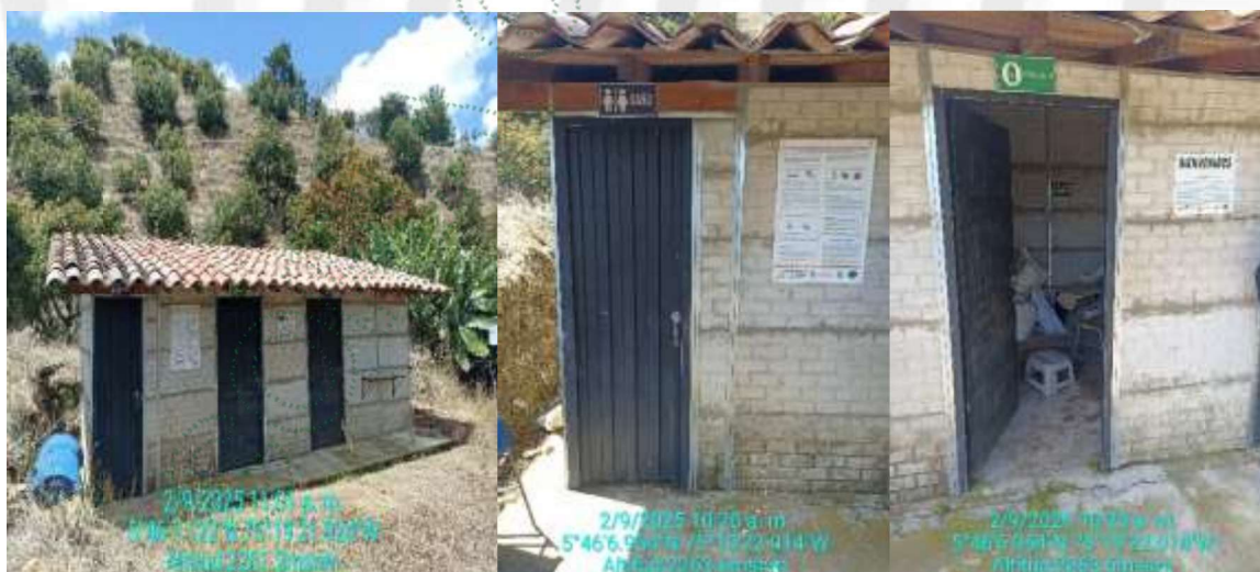
Vivienda con unidad sanitaria y bodega de fertilizantes
