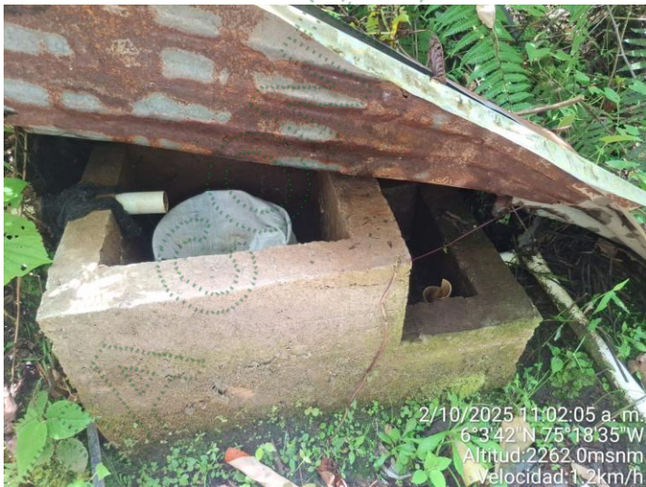
Imagen 3. Obra de captación y control en desuso.
