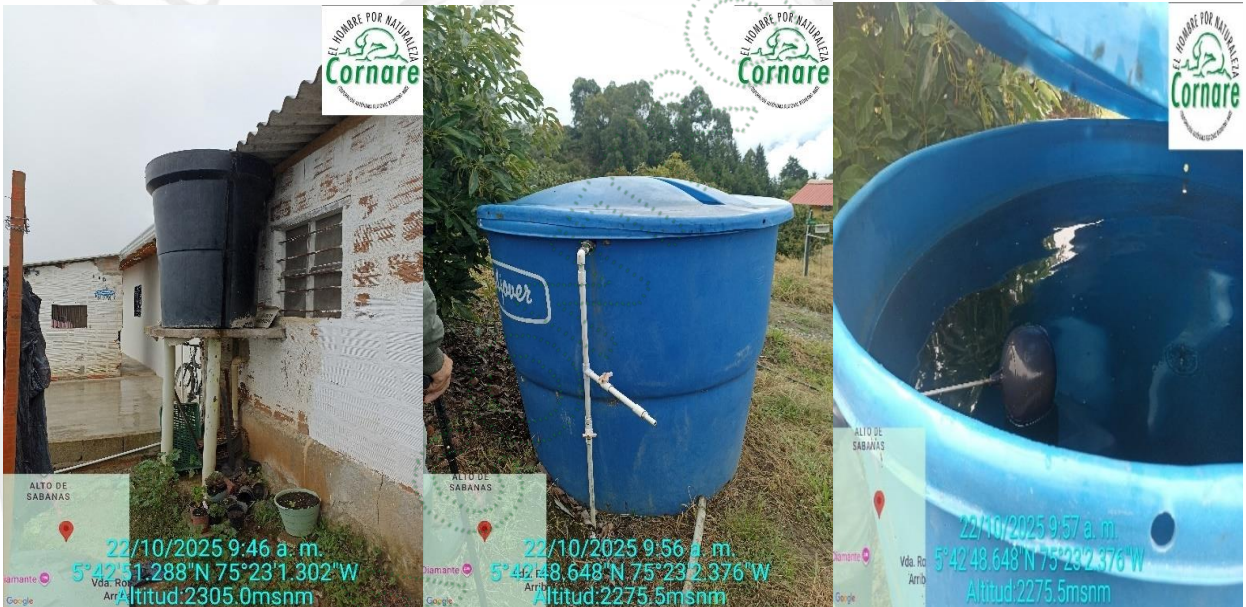
Tanques de almacenamiento con flotador
