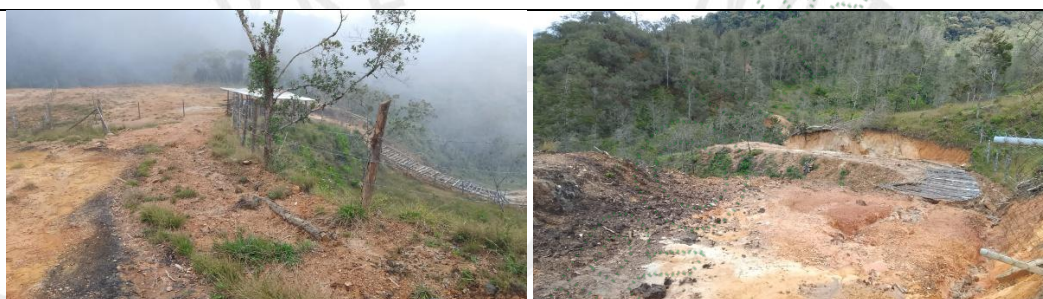
Banqueo y continuidad de la apertura de la vía.
