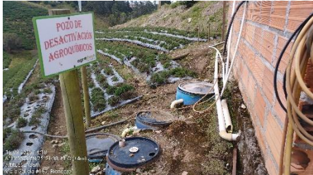
Imágenes relacionadas con el Sistema de Tratamiento de Aguas Residuales no Domésticas o pozo de desactivación (STARnD).
