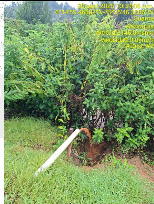
Imagen N° 5. Descarga de aguas lluvia través de tubería
