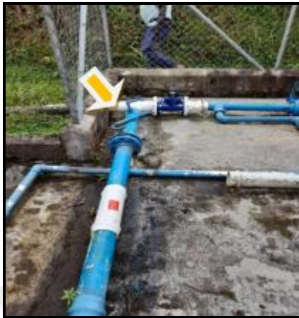
Imagen 3: Fotografías de la separación del sistema que separa el agua tratada del agua cruda – Extraída del radicado CE-02129-2025, del 06/02/2025
