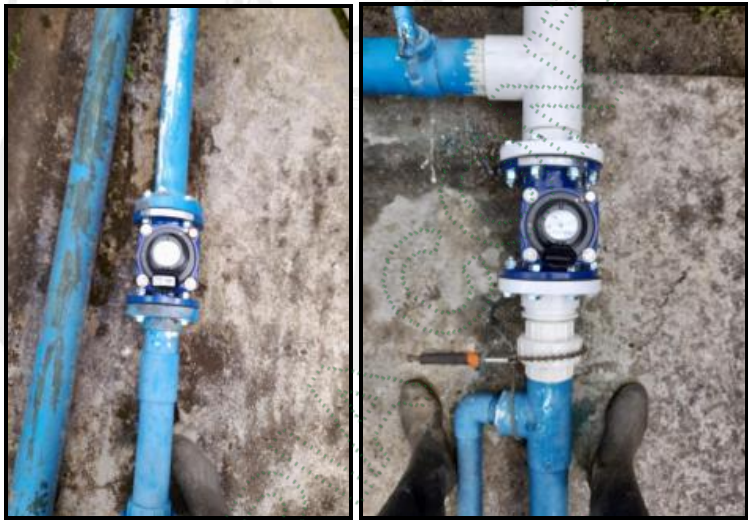
Imágenes 1 y 2: Fotografías de las macromedidores instalados – Extraídas del radicado CE-02129-2025, del 06/02/2025
