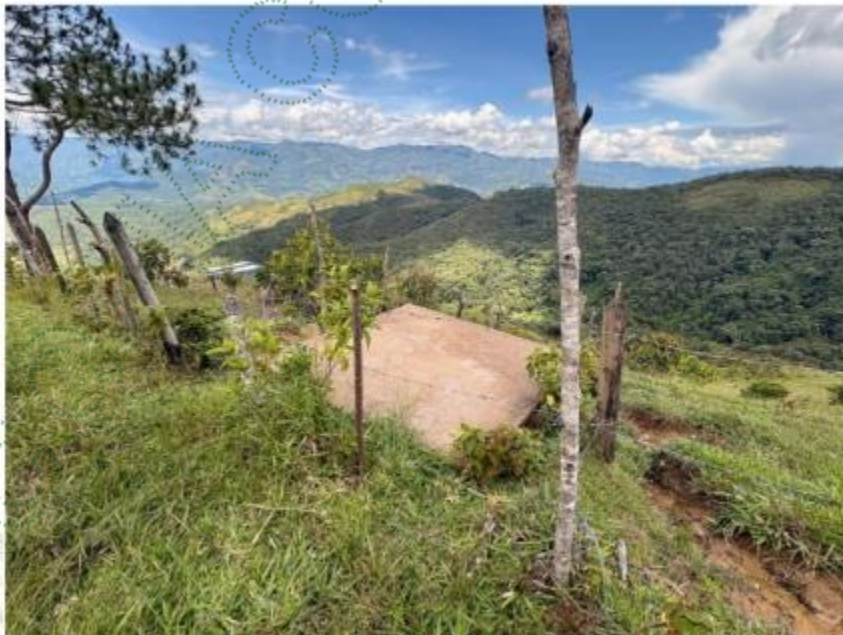
Imagen 4 Pozo Séptico Mampostería.
