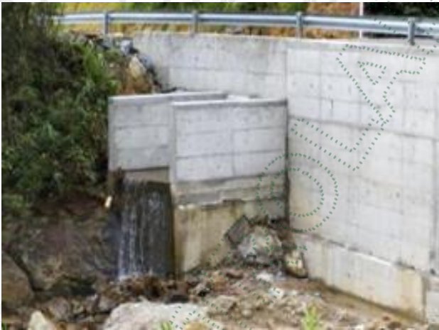
Estructura de descole construida en campo – Obra (56- 16 (72)
