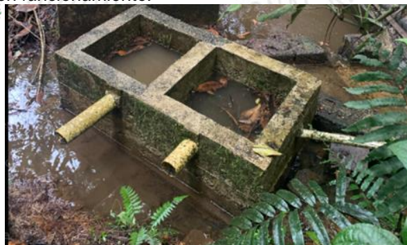
Tanque de almacenamiento 9 usuarios
