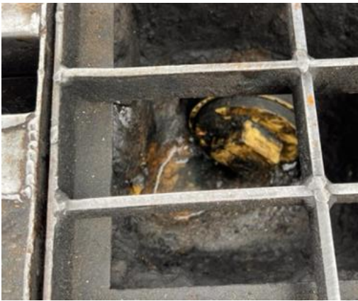
Foto 4 y 5. Tapón ubicado en la entrada de la tubería que conduce al sistema de trampa grasa para el manejo de las ARnD. Fuente: Cornare 2025
