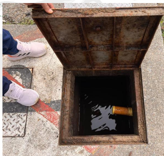
Fotos 2 y 3. Sistema de tratamiento de ARnD (Trampa grasa) de la EDS El Motorista. Fuente: Cornare 2025
