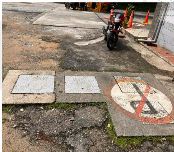
Fotos 2 y 3. Sistema de tratamiento de ARnD (Trampa grasa) de la EDS El Motorista. Fuente: Cornare 2025
