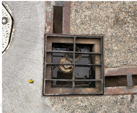
Foto 4 y 5. Tapón ubicado en la entrada de la tubería que conduce al sistema de trampa grasa para el manejo de las ARnD. Fuente: Cornare 2025
