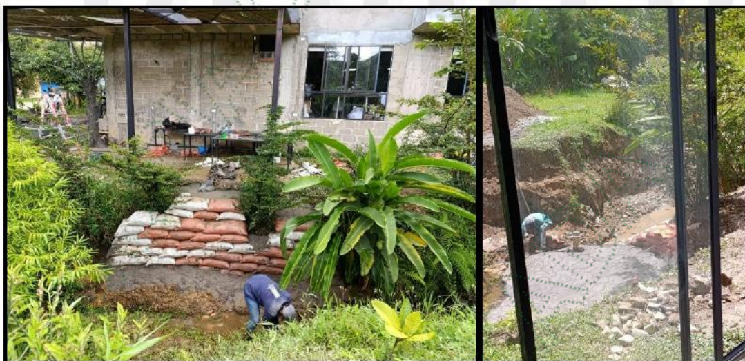
Imagen 7. Cornare. 2025. Implementación de bolsacreto y sellado del lecho del cauce para mitigar procesos de erosión.
