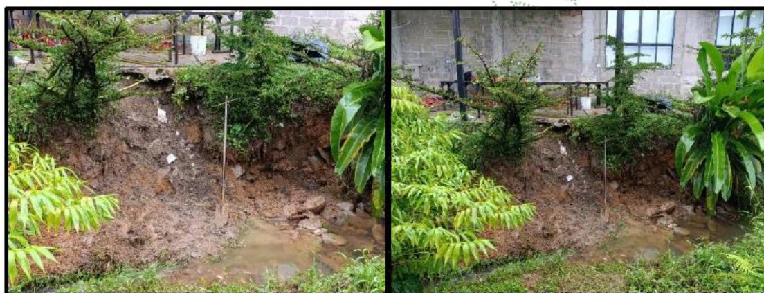
Imagen 6. Cornare. 2025. Socavación y erosión de la margen derecha del cauce de la quebrada.
