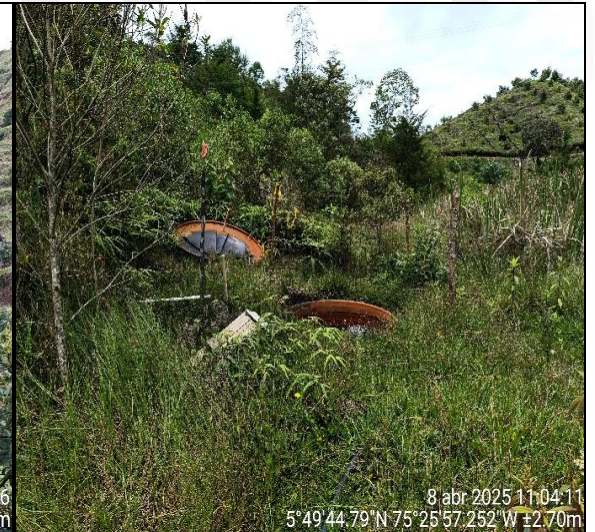
Tanque de almacenamiento
