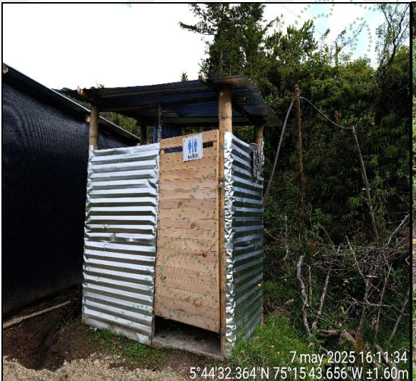
Unidad sanitaria trabajadores
