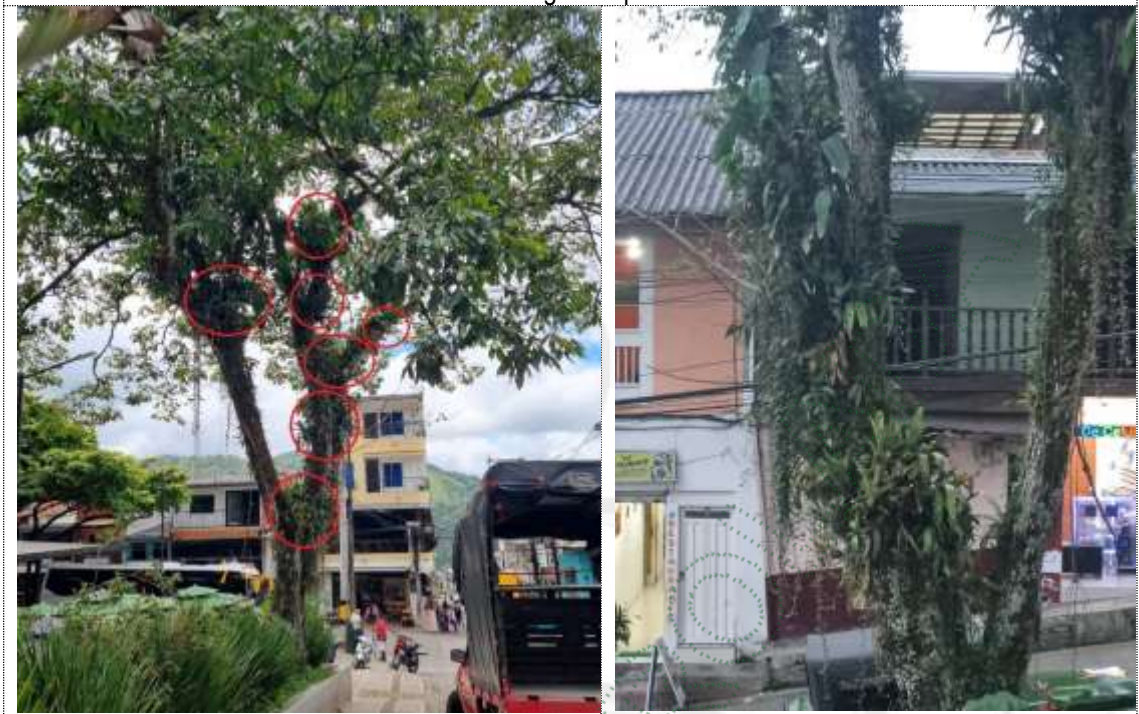
Sobrecarga de epífitas.
