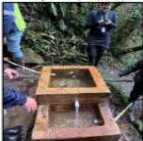
Imagen 7. Aranzalez, S.J. (2025). Obra de Captación # 3, El Retiro.
