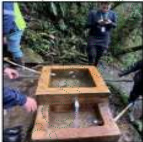
Imagen 7. Aranzalez, S.J. (2025). Obra de Captación # 3, El Retiro.
