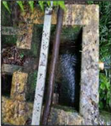
Imagen 2. Zapata, E.S. (2025). Obra de Derivación, El Retiro.
