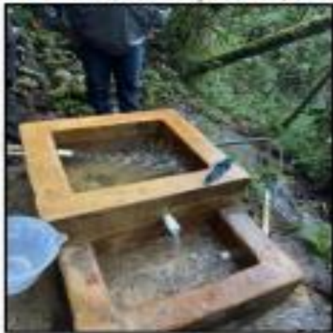
Imagen 8. Aranzález, S.J. (2025). Obra de Captación # 3, El Retiro.
