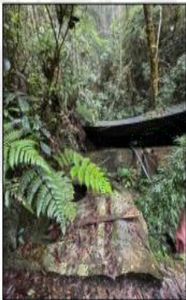
Imagen 1. Aranzalez, S.J. (2025). Obra de Captación # 1, El Retiro.
