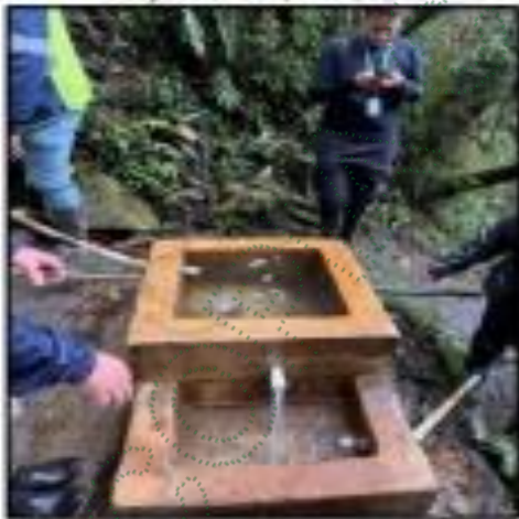
Imagen 7. Aranzález, S.J. (2025). Obra de Captación # 3, El Retiro.
