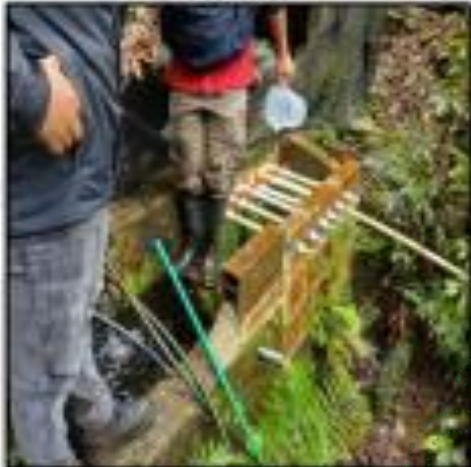
Imagen 5. Zapata, E.S. (2025). Derivación Obra de Captación # 2, El Retiro.
