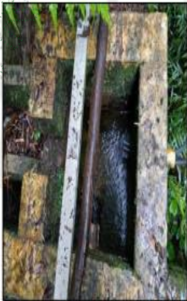
Imagen 2. Zapata, E.S. (2025). Obra de Derivación, El Retiro.
