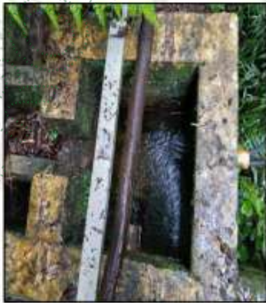
Imagen 2. Zapata, E.S. (2025). Obra de Derivación, El Retiro.
