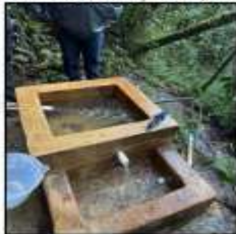
Imagen 8. Aranzalez, S.J. (2025). Obra de Captación # 3, El Retiro.
