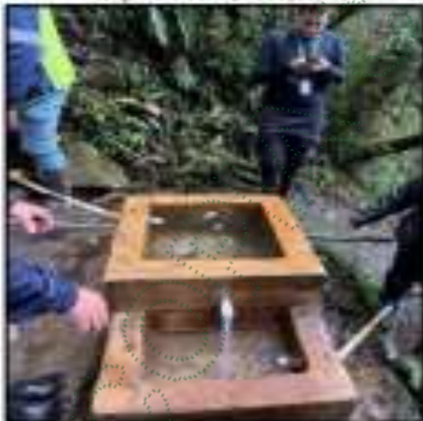
Imagen 7. Aranzalez, S.J. (2025). Obra de Captación # 3, El Retiro.
