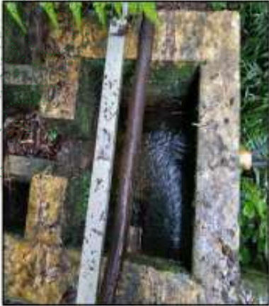
Imagen 2. Zapata, E.S. (2025). Obra de Derivación, El Retiro.
