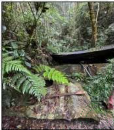
Imagen 1. Aranzalez, S.J. (2025). Obra de Captación # 1: El Retiro.
