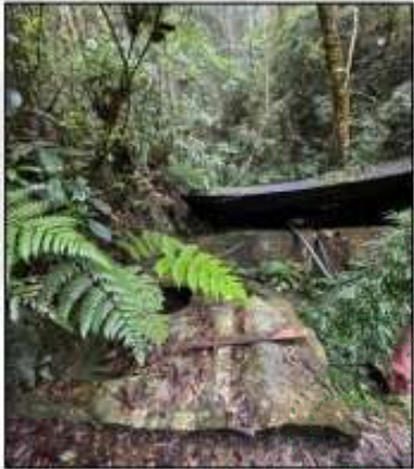
Imagen 1. Aranzalez, S.J. (2025). Obra de Captación # 1: El Retiro.
