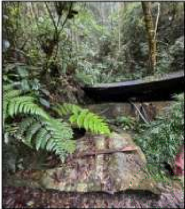
Imagen 1. Aranzalez, S.J. (2025). Obra de Captación # 1: El Retiro.
