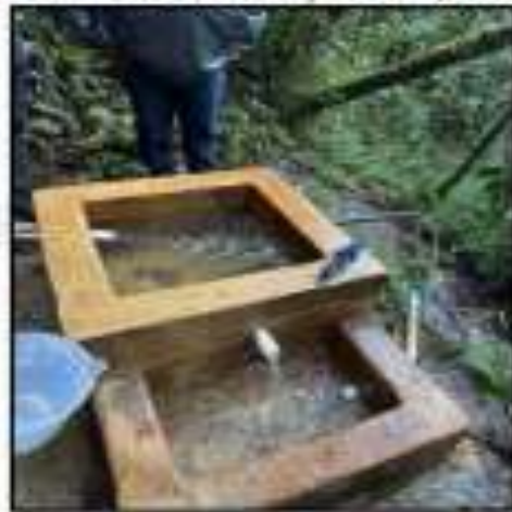
Imagen 8. Aranzalez, S.J. (2025). Obra de Captación # 3, El Retiro.
