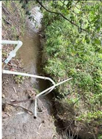
Actualmente el recurso es bombeado directamente de la Quebrada La Lajita por medio de una motobomba de 2hp, sin embargo, en la visita se informó que desean cambiar el punto de captación aproximadamente a 300m aguas abajo, derivar por gravedad a un pozo de succión y de este bombear a un reservorio impermeabilizado.
