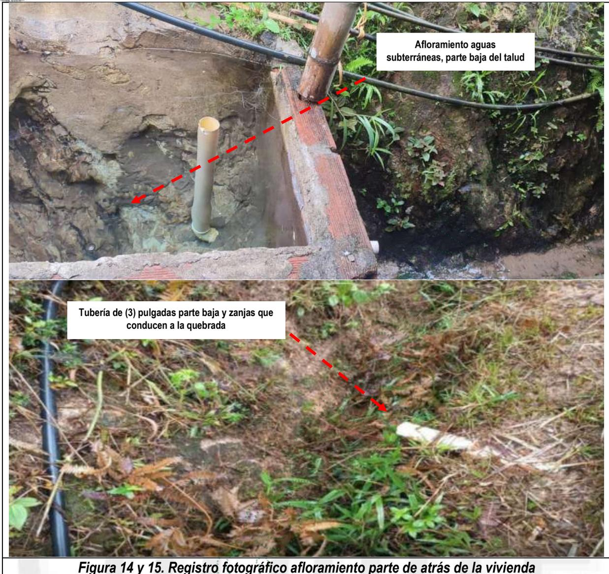
**Figura 14 y 15. Registro fotográfico afloramiento parte de atrás de la vivienda**
