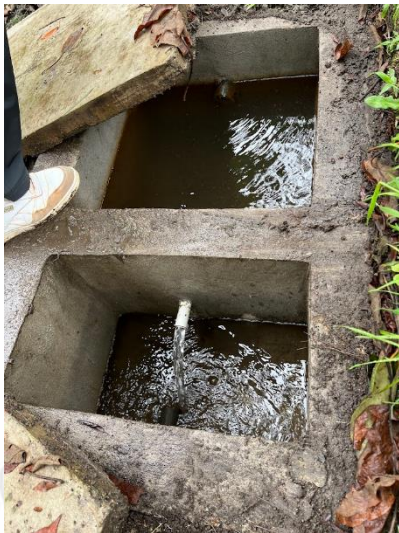
Imagen 3. Obra de control de caudal (tubería de reboce) Imagen 4. Obra de control de caudal
