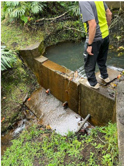
Imagen 3. Obra de control de caudal (tubería de reboce) Imagen 4. Obra de control de caudal
