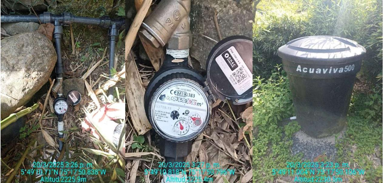
**Micromedidor intalado y tanque de uso domestico**
