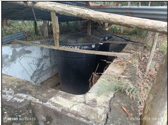
Figura 2. Tanques de almacenamiento
