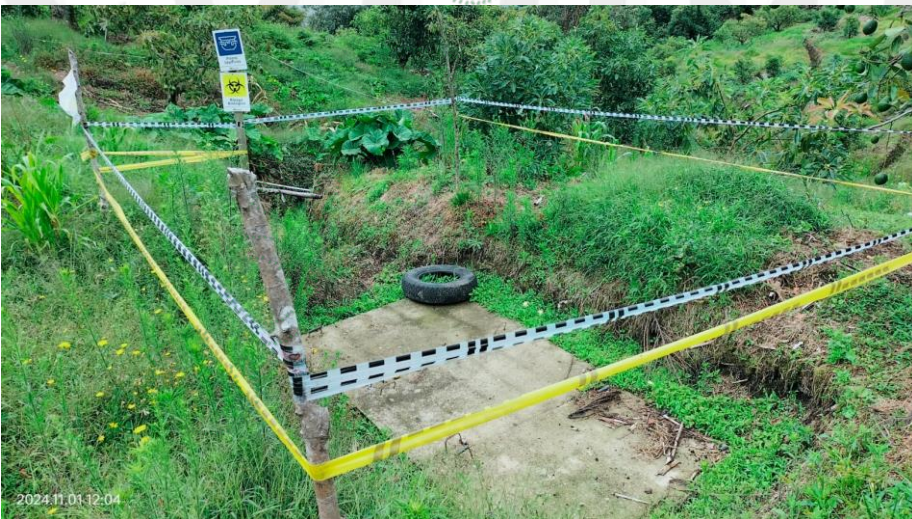
Pozo séptico en mampostería.
