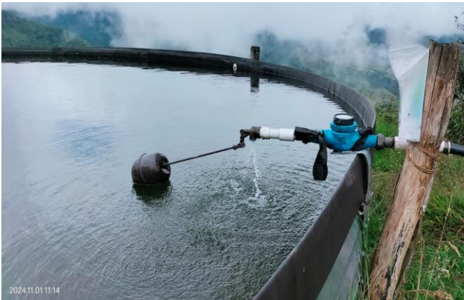
Tanque de almacenamiento tipo australiano y macromedidor
