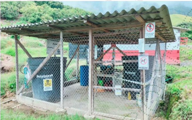
Punto de preparación de mezcla y pozo de desactivación
