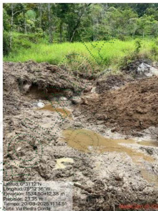
Imagen 4. Enlodamiento y arrastre de sedimentos.
