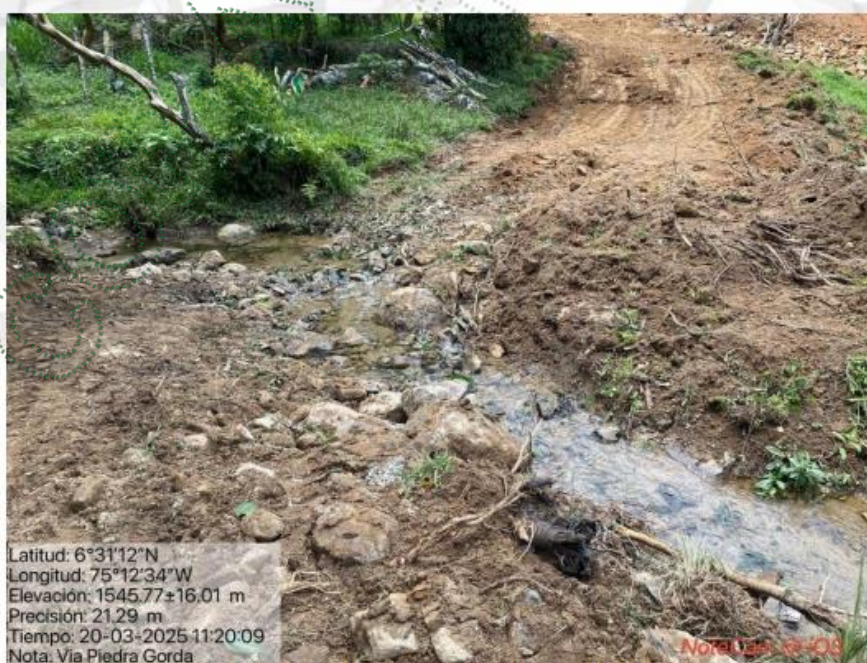
Imagen 5. Ocupación de cauce a la fuente Sin nombre.
