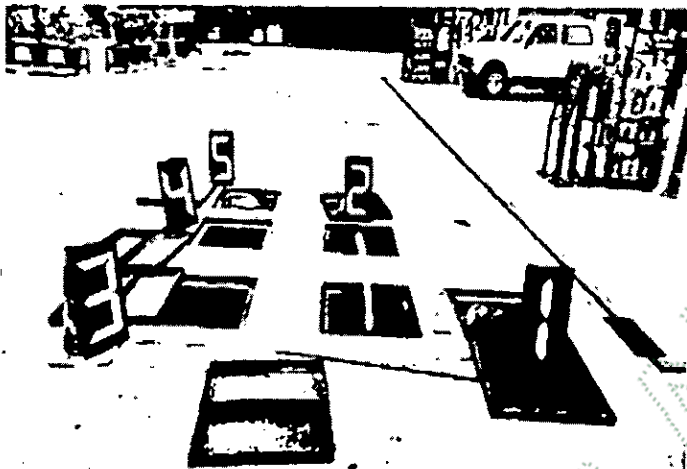
Fotografía 1. Trampa de grasas
