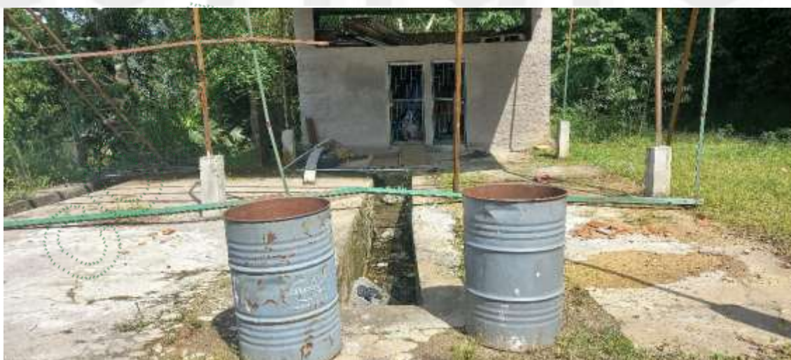
Img 3: Lavadero de carros fuera de servicio. Fuente: Cornare,2024
