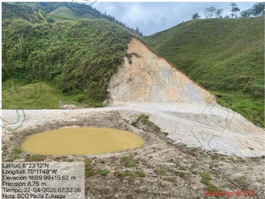
Imagen 2. Excavación y adecuación de terreno.
