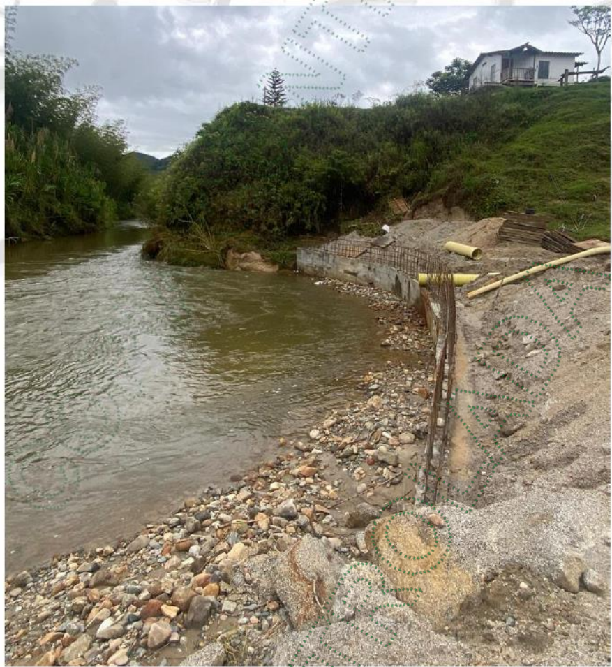
Imagen 3. Vivienda y jarillón en construcción.
