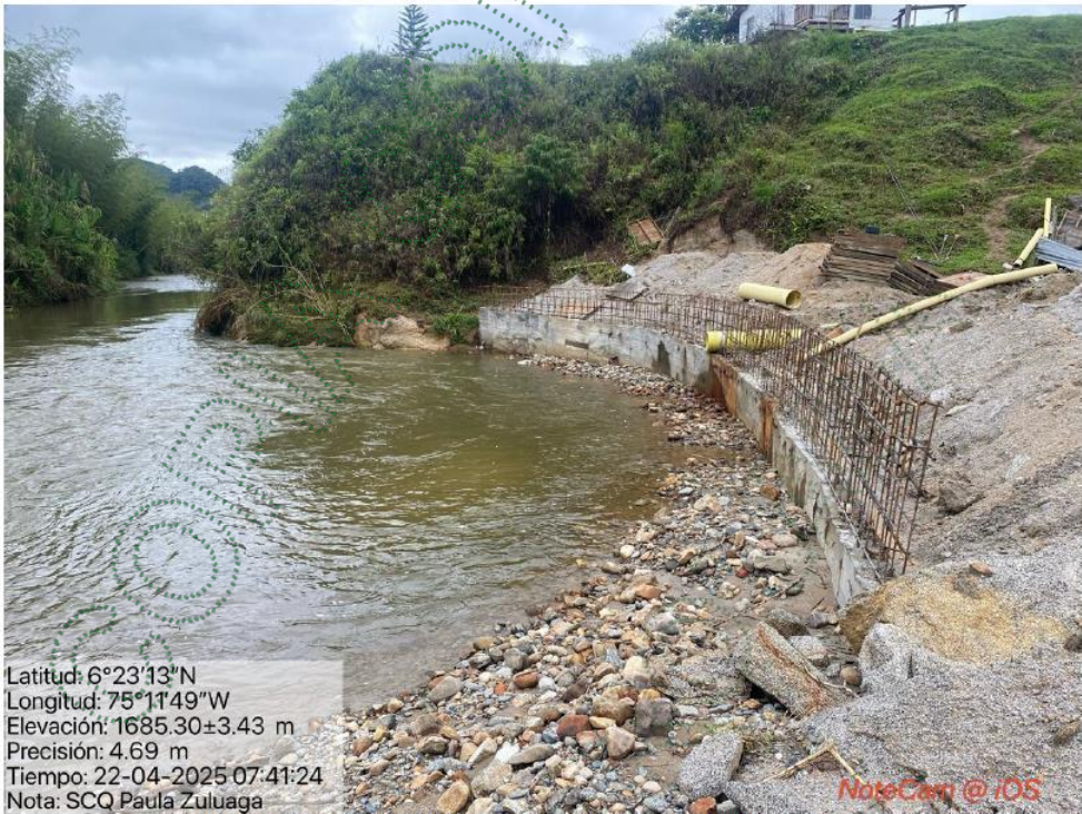
Imagen 4. Jarillón en construcción sobre la ríbera del Río Concepción.
