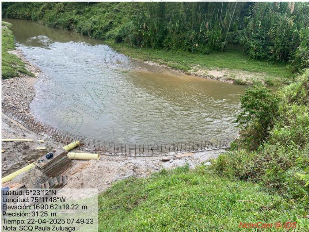
Imagen 5. Jarillón en construcción sobre la ribera del Río Concepción.
