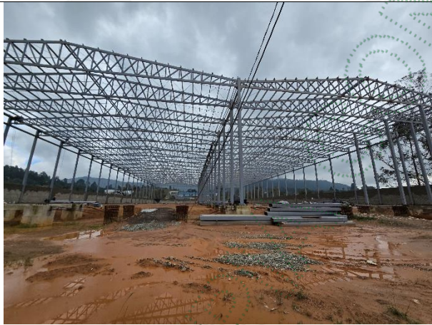
Avance de obras
