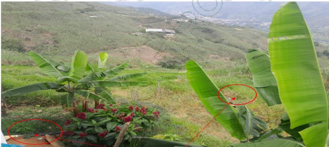
Imagen de la manguera de conducción de aguas servidas, y punto de la descarga a suelo abierto.
