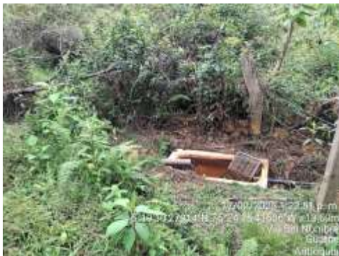
Imagen 3. Punto de captación aforo
