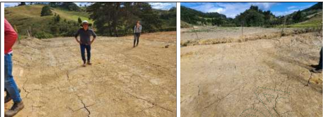
Sitio destinado para instalacion del STARD.
