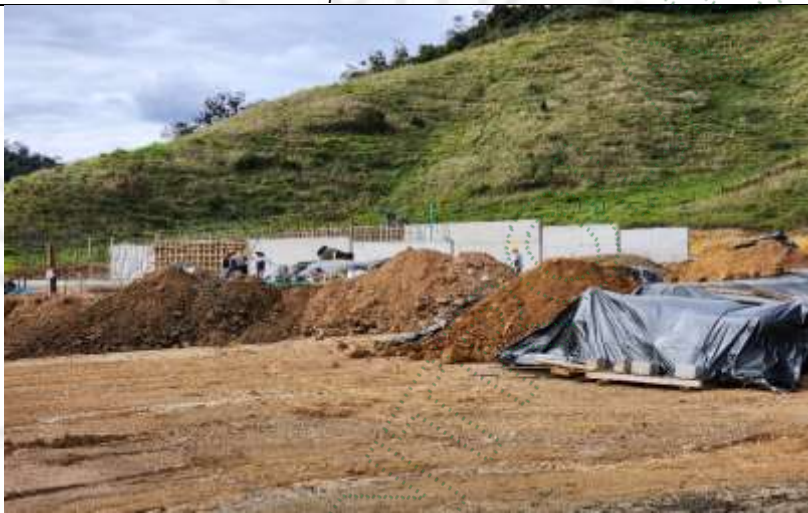
Compostera en proceso de construcción
