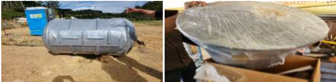
STARD prefabricado comprado para instalación
