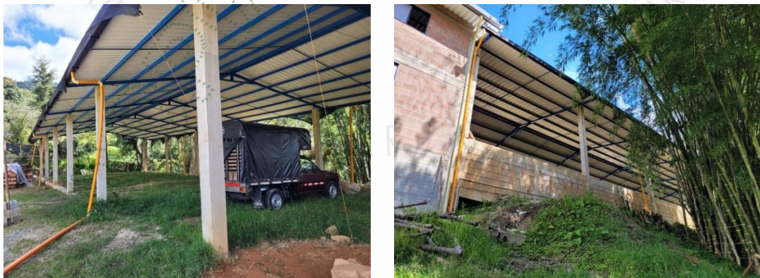
Figura 6. Infraestructura existente, observada durante la visita
