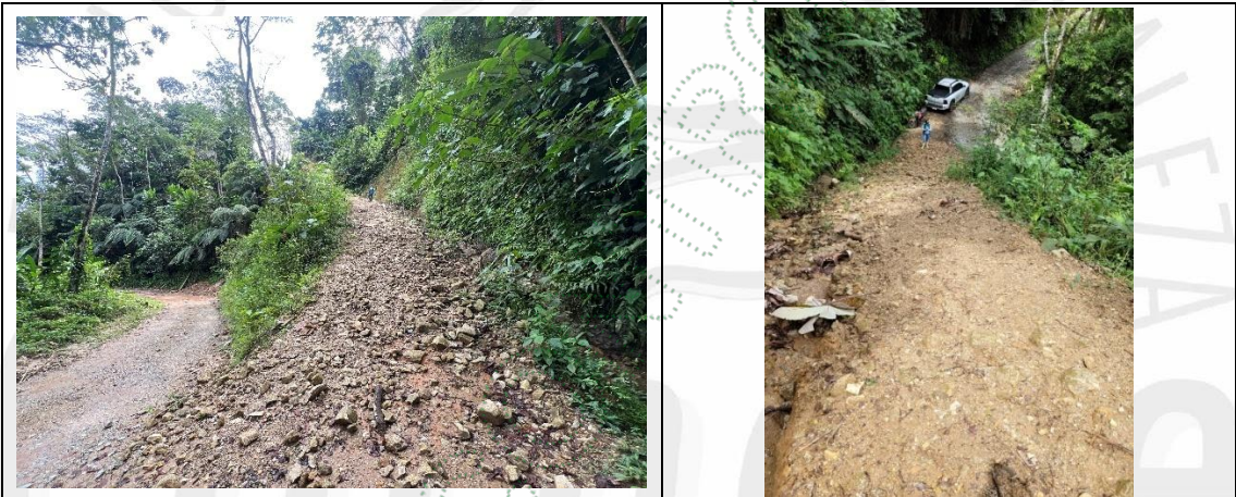
Imagen 9. Estado Deslizamiento 1, que es el inicio de la vía sin permiso desde la vía a casa de máquinas de la CH San Miguel. evidenciado en la visita técnica de control y seguimiento (25 de febrero de 2025)
