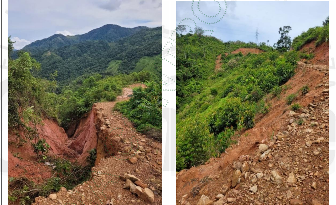
Imagen 19. Estado Nueva apertura de vía ubicada en predio identificado con FMI 018-109110, evidenciado en la visita técnica de control y seguimiento (25 de febrero de 2025)
