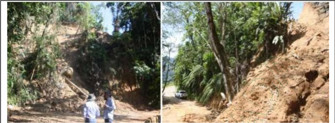
Imagen 8. Estado Deslizamiento 1, que es el inicio de la vía sin permiso desde la vía a casa de máquinas de la CH San Miguel, evidenciado en la visita técnica de atención a queja ambiental (14 de agosto de 2023)
