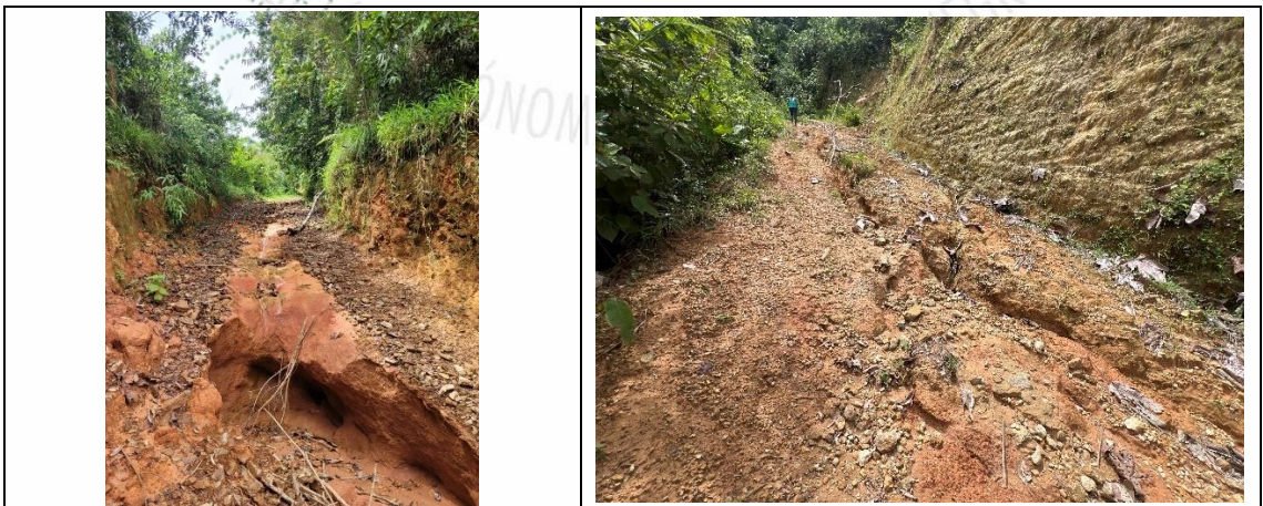
Imagen 13. Estado Surcos en los costados y desprendimientos del terreno de la vía sin permiso, evidenciado en la visita técnica de control y seguimiento (25 de febrero de 2025)
