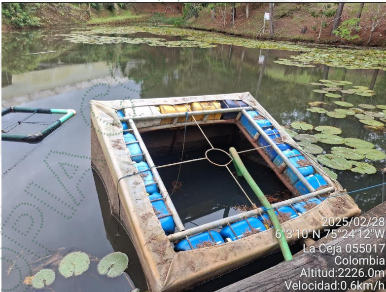
Imagen 2. Sistema de bombeo implementado en la fuente Afloramiento
