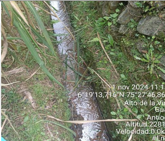
Ilustración N° 7. Canal en concreto construido en el encole para el encauzamiento de la fuente
