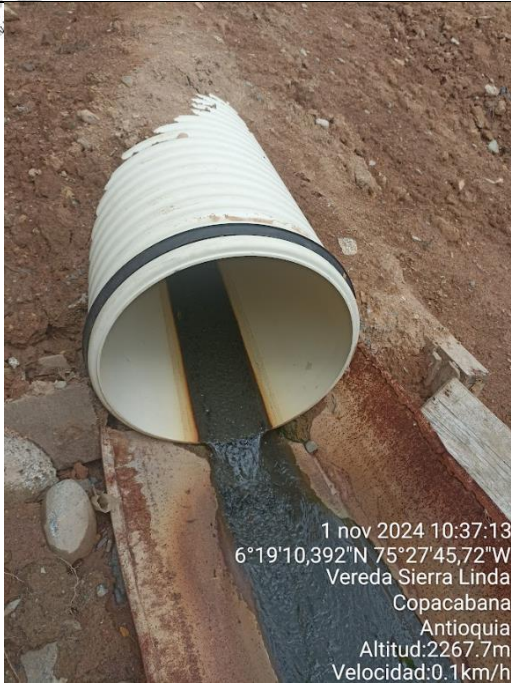
Ilustración N° 9. Descole de tubería construida
