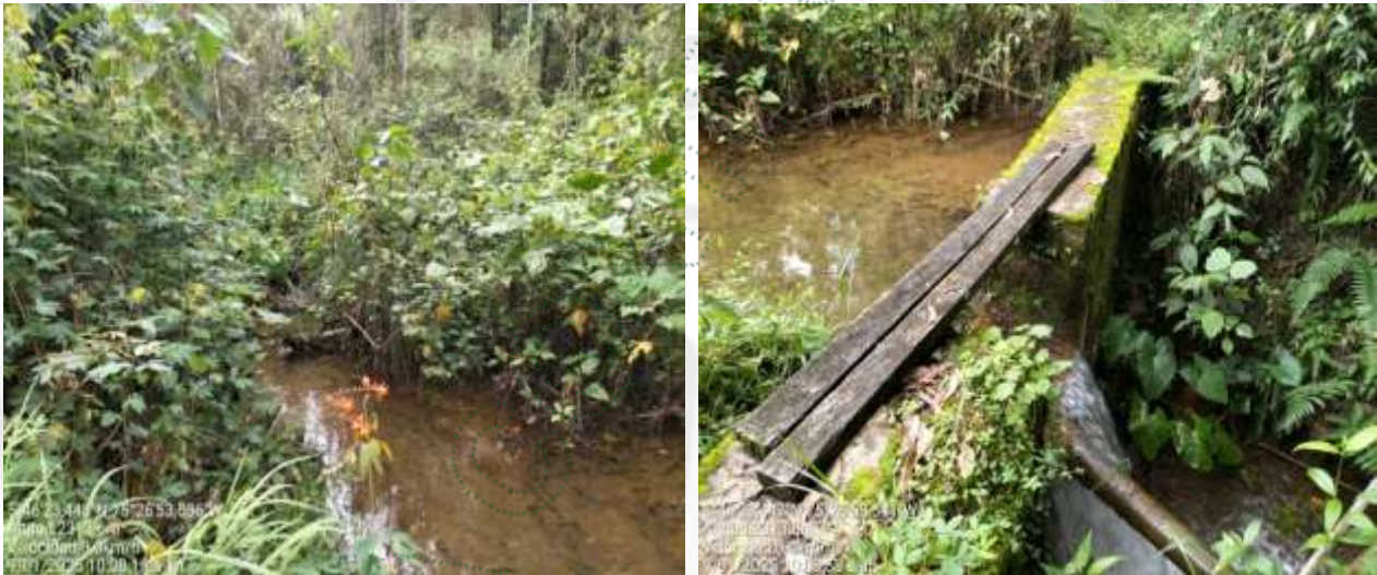
Imagen 5: Obras construidas en la captación Manga Grande.
