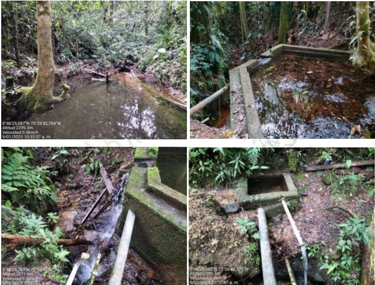
Imagen 5: Obras construidas en la captación Los Dolores.
