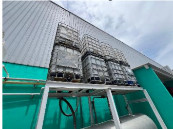
Imagen 1.Sistema de almacenamiento agua lluvia
