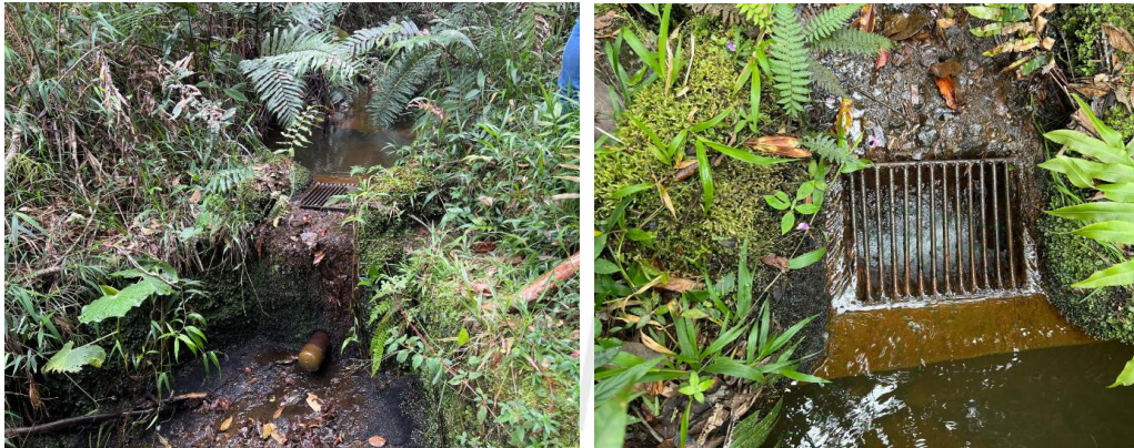
Figura 3. Bocatoma Q. La Guagua. Fuente: Cornare 2025
