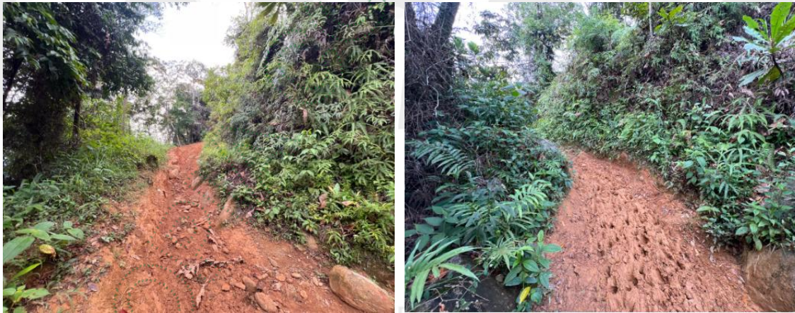
Figura 2 y 3. Estado del sitio donde se había realizado actividades de movimiento de tierras con maquinaria para ampliación de una vía veredal. Fuente: CORNARE 2024
