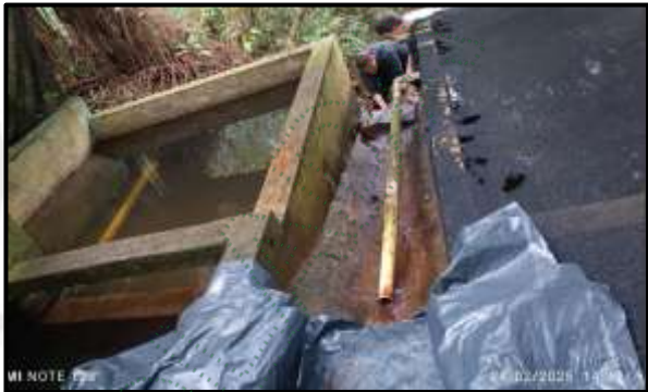
Imágenes 8 y 9: Fuente hídrica “El Saladito del Monte” y obra de captación y derivación de caudal existente
