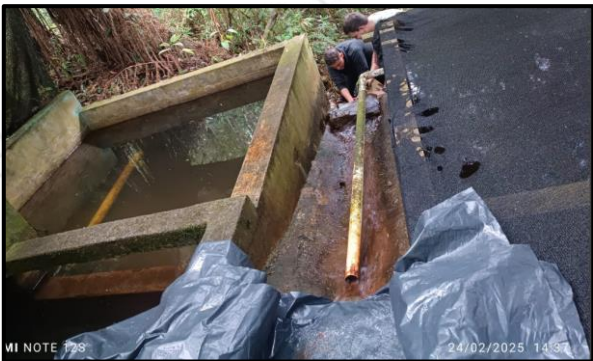
Imágenes 7 y 8: Fuente hídrica “El Saladito del Monte” y obra de captación y derivación de caudal existente
